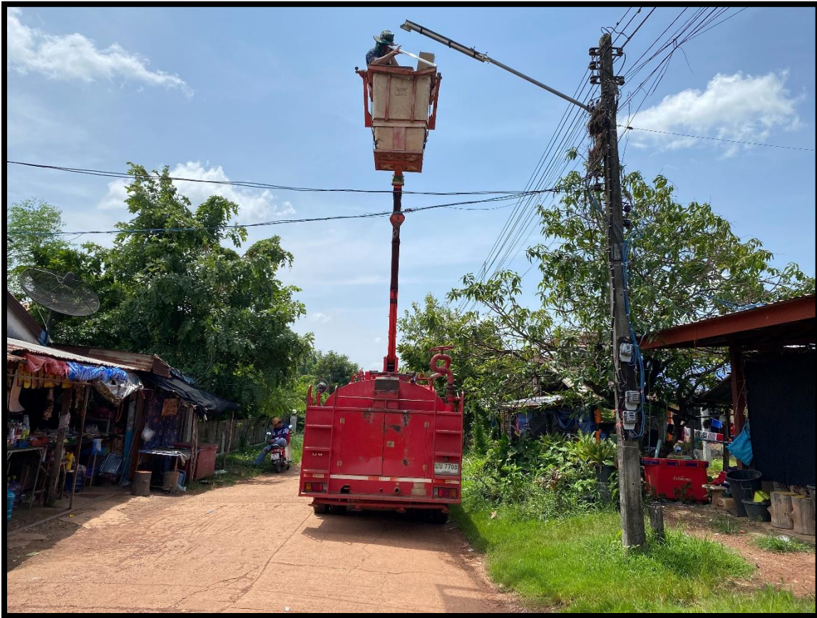
ซ่อมแซมไฟฟ้าส่องสว่างบริเวณบ้านนาजार หมู่ที่ 2 และบ้านดู่ หมู่ที่ 6
